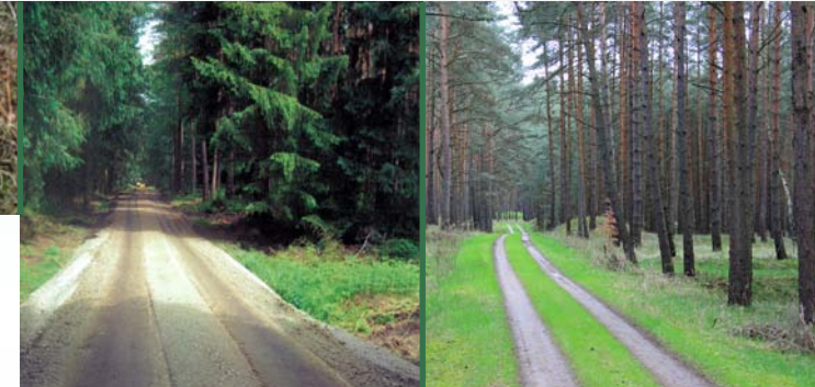
Weg während der Instandsetzung
