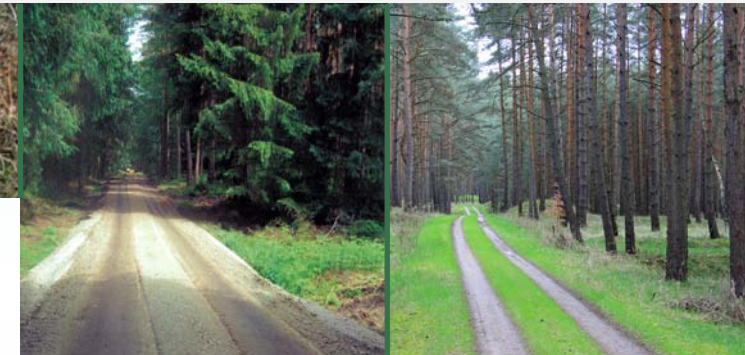
Weg während der Instandsetzung
