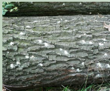
Massiver Befall eines Holzpolters durch technische Schädlinge
