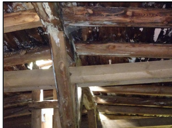
Nebengebäude Dach Detail
