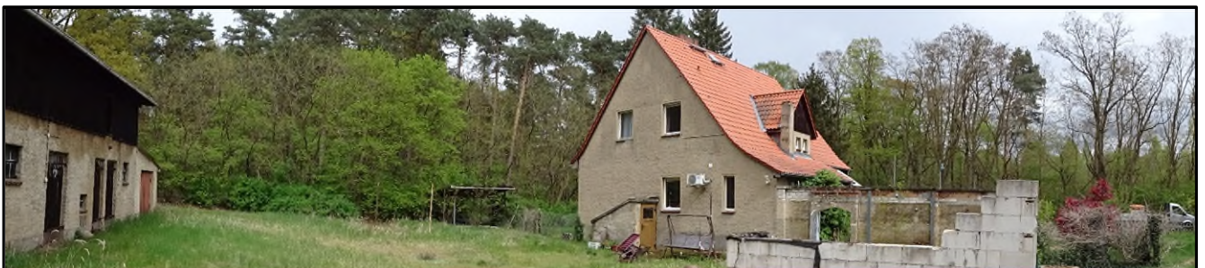
Ansicht von West
