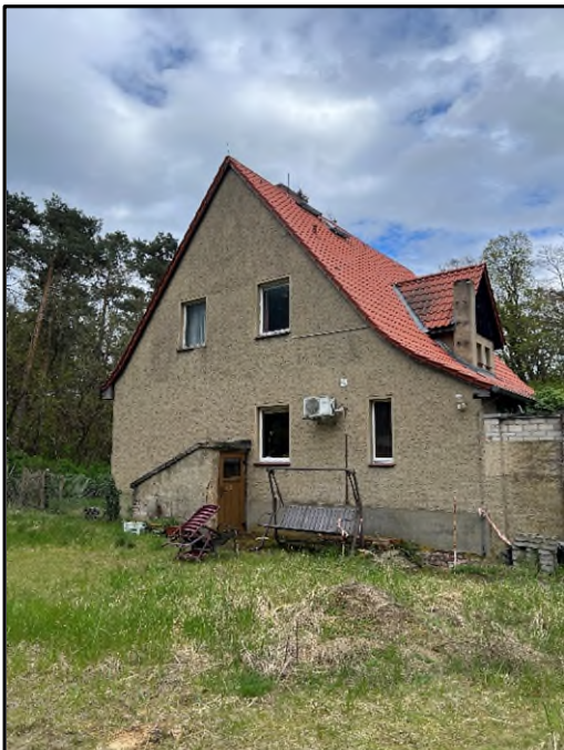
Ansicht Hofseite Nord
