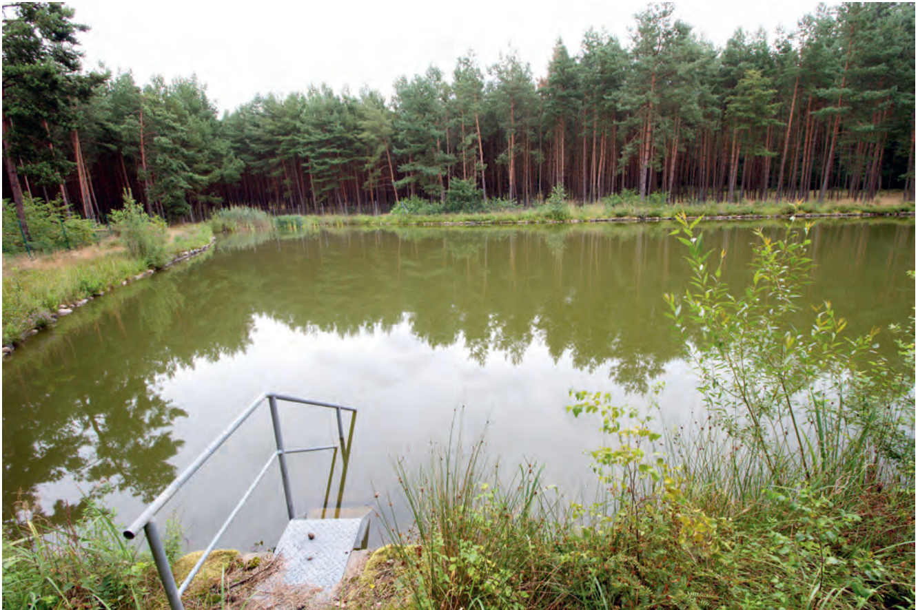
In die Umgebung eingebetter Feuerlöschteich mit Zugang zur Wasserentnahme für die Feuerwehr Foto: A. Neumann
