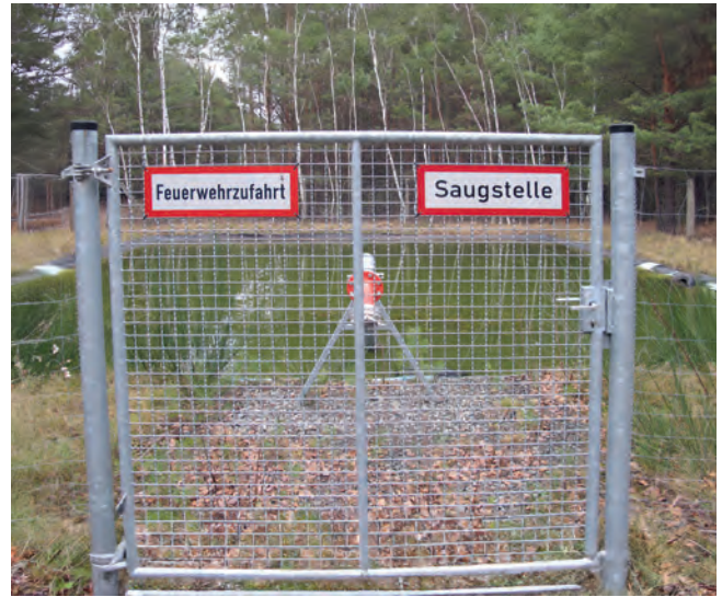
Neu angelegter Feuerlöschteich im besonders waldbrandgefährdeten Süden Brandenburgs Foto: J. Engel
