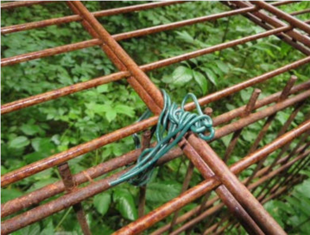
Abb. 15: Alle Teile des Bausatzes werden mittels Draht verbunden
