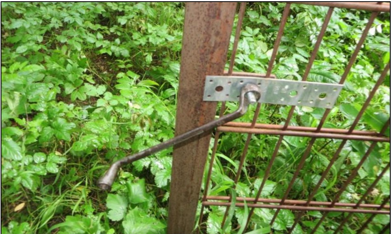
Abbildung 5: Lediglich der Fangtorrahmen wird mit den Seitenteilen verschraubt (Foto: Dr. E. Gleich)
