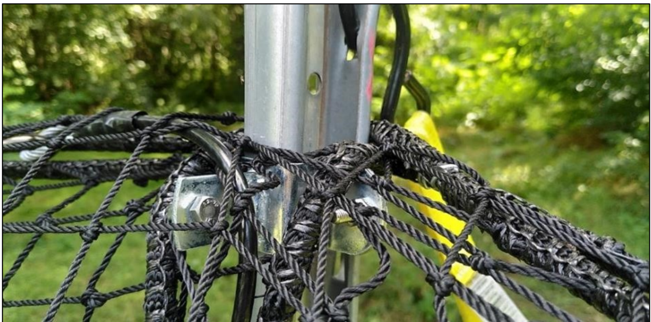
Abbildung 15: Schelle am Pfahl fälschlicherweise mit Nase nach innen montiert (Foto: Dr. C. Gremse)
