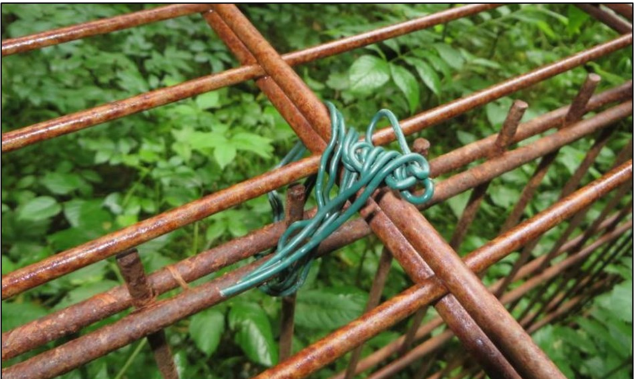
Abbildung 4: Alle Teile des Bausatzes werden mit Draht verbunden (Foto: Dr. E. Gleich)
