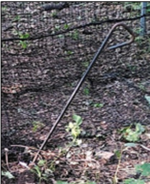
Abbildung 19: Netzanker etwa 45° nach innen geneigt und das Auge nach innen geöffnet (Foto: Dr. C. Gremse)
