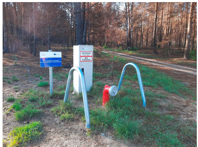
Abbildung 14: Löschwasserentnahmestellen – Flachspiegelbrunnen (links) und Tiefbrunnen mit Pumpe (rechts) (Quelle: LFB)
