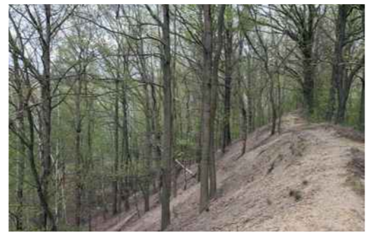
Abbildung 24: „Kippenrandbefestigung“ – Böschungsbefestigung mit Trauben-Eiche und Rot-Eiche um 1950, nach vorherigen Rutschungen damals eine vorrangige Aufgabe der forstlichen Rekultivierung.
