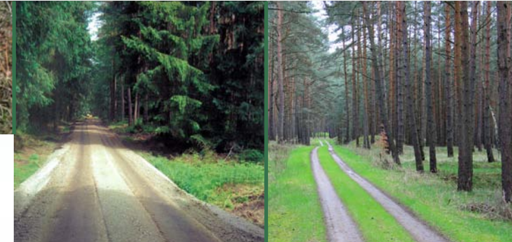
Weg während der Instandsetzung
